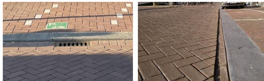
Afbeelding 11 en 12 De hoogte van de trottoirband kan verschillen. Bij een valkolk kan de trottoirband verder naar beneden worden gebracht dan bij een kolk in de band. In beide gevallen is deze laag genoeg zodat alle voertuigen gemakkelijk de hub in kunnen rijden. In de praktijk parkeren fietsen en brommers nu ook al op het trottoir.
